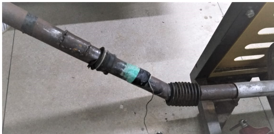
Figura 14 – Instalação do termopar na carcaça da válvula termostática.
